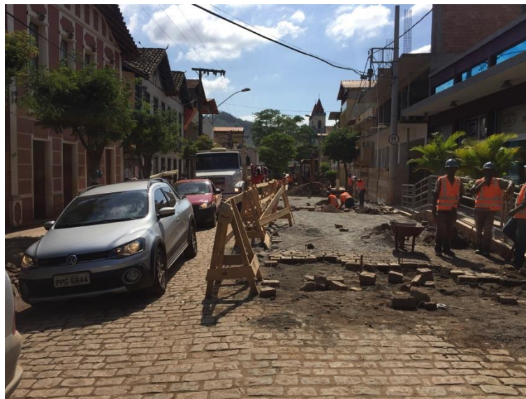
Figura 20 - Imagem do município de Barra Longa após o desastre
