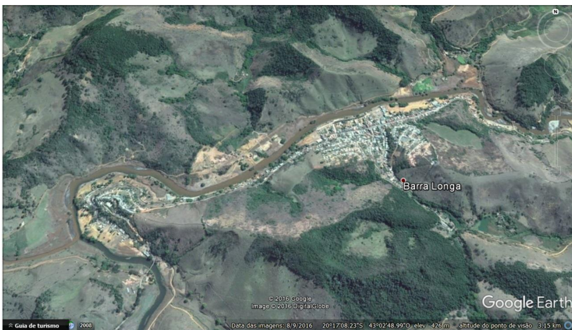
Figura 6 - Vista aérea de Barra Longa um ano após desastre
