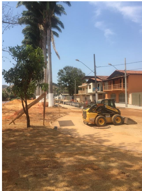
Figura 18 - Imagem do município de Barra Longa após o desastre - a marca da lama pintada por tinta branca nos coqueiros
