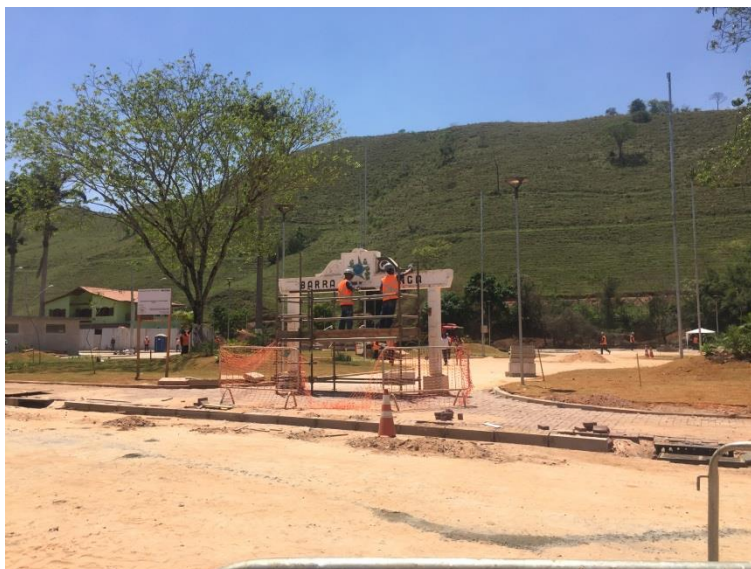
Figura 21 - Imagem do município de Barra Longa após o desastre
