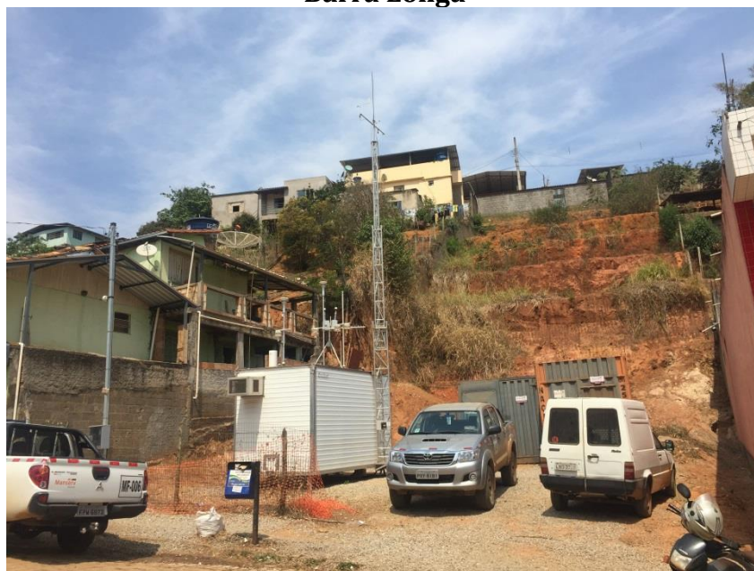
Figura 40 - Equipamento de monitoramento do ar, automático, instalado em Barra Longa
