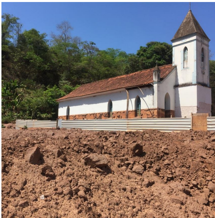
Figura 23 - Imagem da região de Gesteira após o desastre
